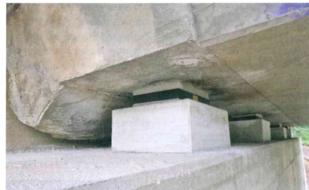
13 Überbaulagerung auf neuem Widerlager © Becker Ingenieure GmbH
