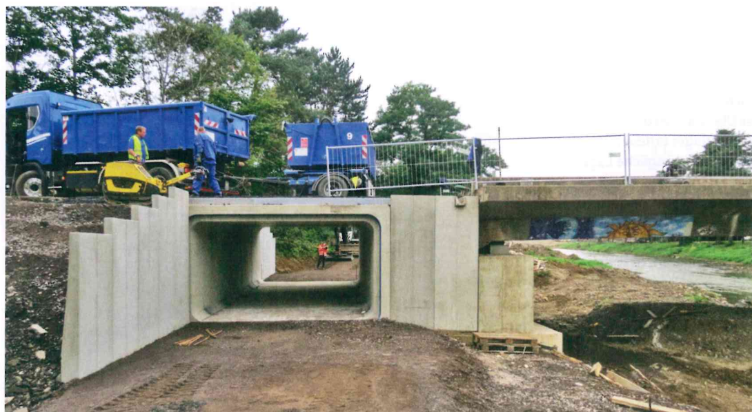
14 Fußgängerquerung nach Fertigstellung © Becker Ingenieure GmbH
