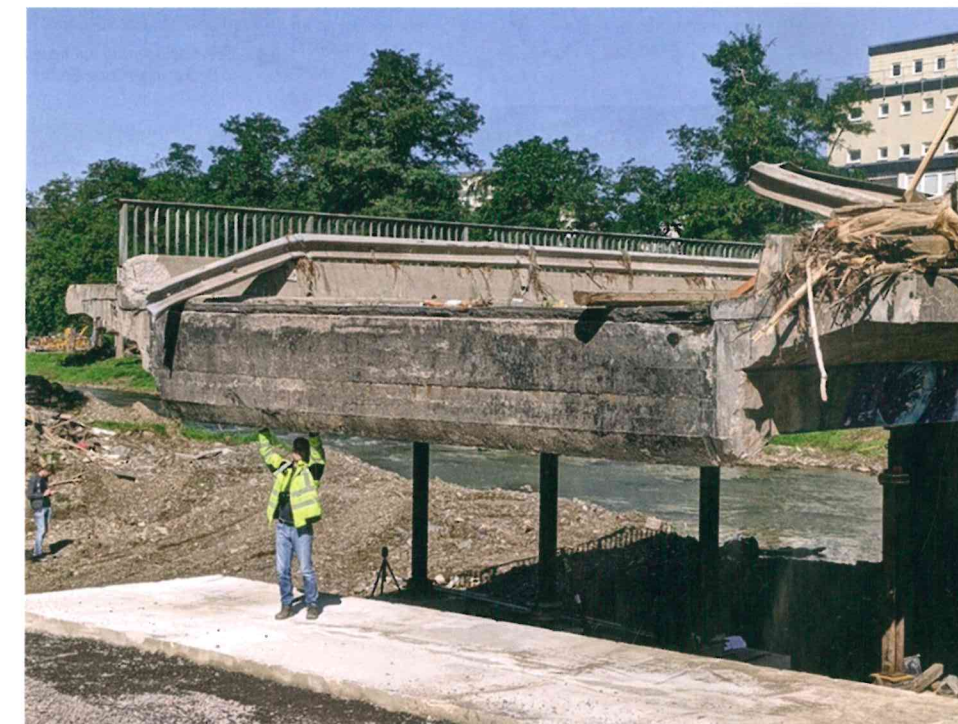
12 Bauwerkszustand nach dem Anheben © Becker Ingenieure GmbH
